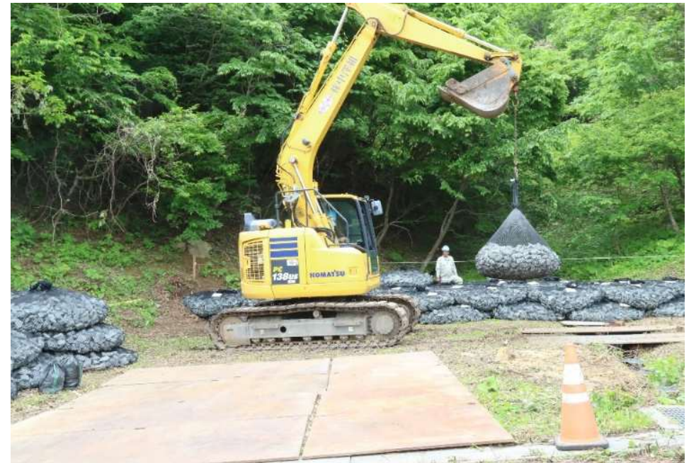
大型土のう設置
