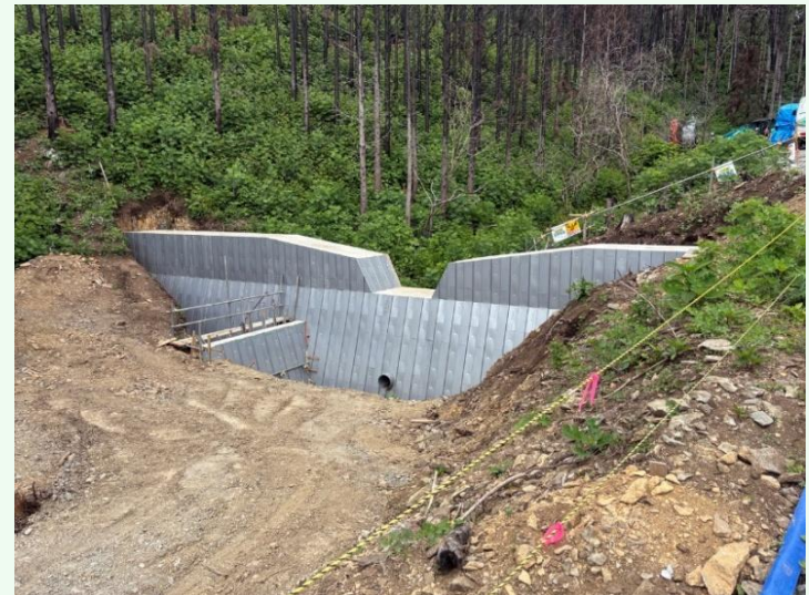
整備が進む治山ダム
