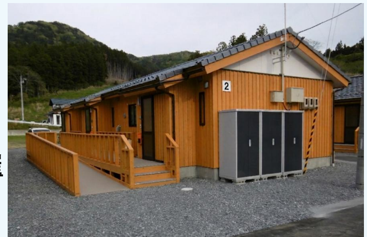
建設型応急仮設住宅（蛸ノ浦）
