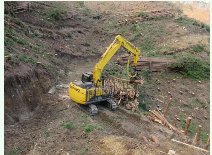
伐採現場（三陸町綾里字熊之入地内）
